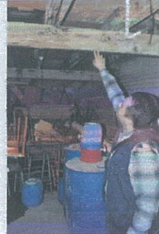
Fotografía N°2: Inspección Inmueble Colegio Ciudad de Portovelo
